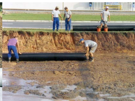
Riduzione della fondazione granulare
