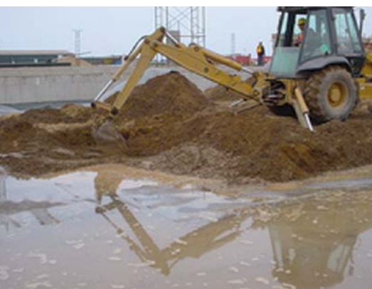
Accesso su suolo bagnato/soffice
