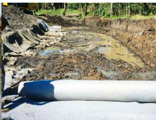
Stabilizzazione del sottofondo
